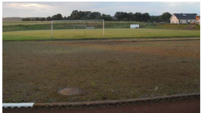
Das Stadion Birkenweg in Rechtenbach
