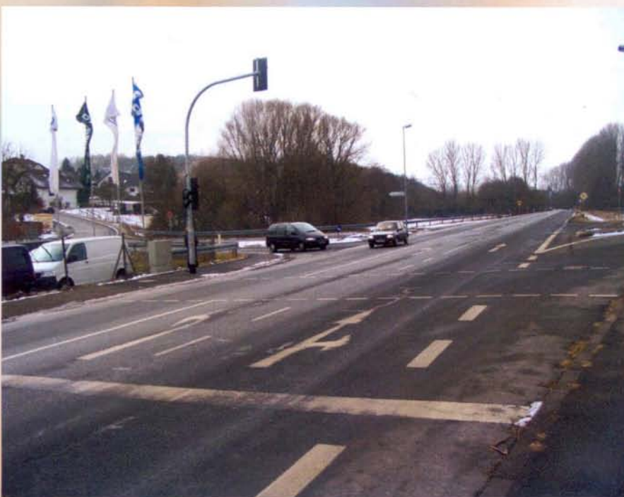
Die Ampelanlage bietet keine ausreichende Sicherheit bei der Überquerung der Hessenstraße
